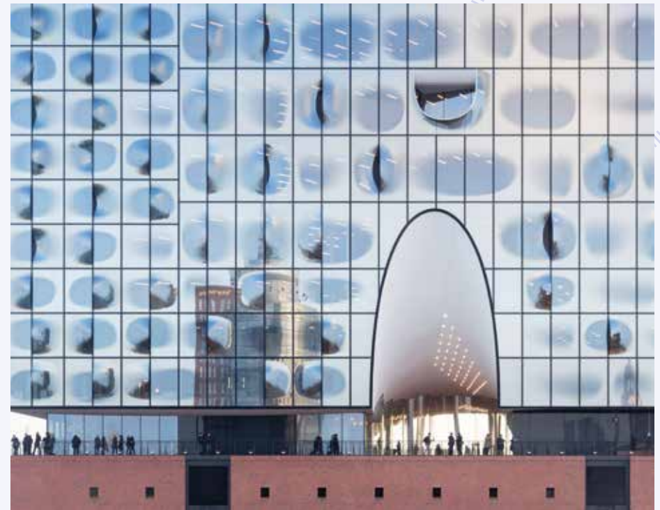
Image: Herzog & de Meuron Elbphilharmonie Hamburg, 2001-2016. Photo © Iwan Baan
